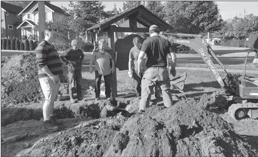
Oprava kanalizácie malým bagrom
